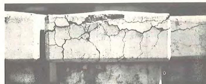
Fig.7. Netrevnedannelser på Ash Creek Bridge i Californien. Efter STANTON (47 S 12).
